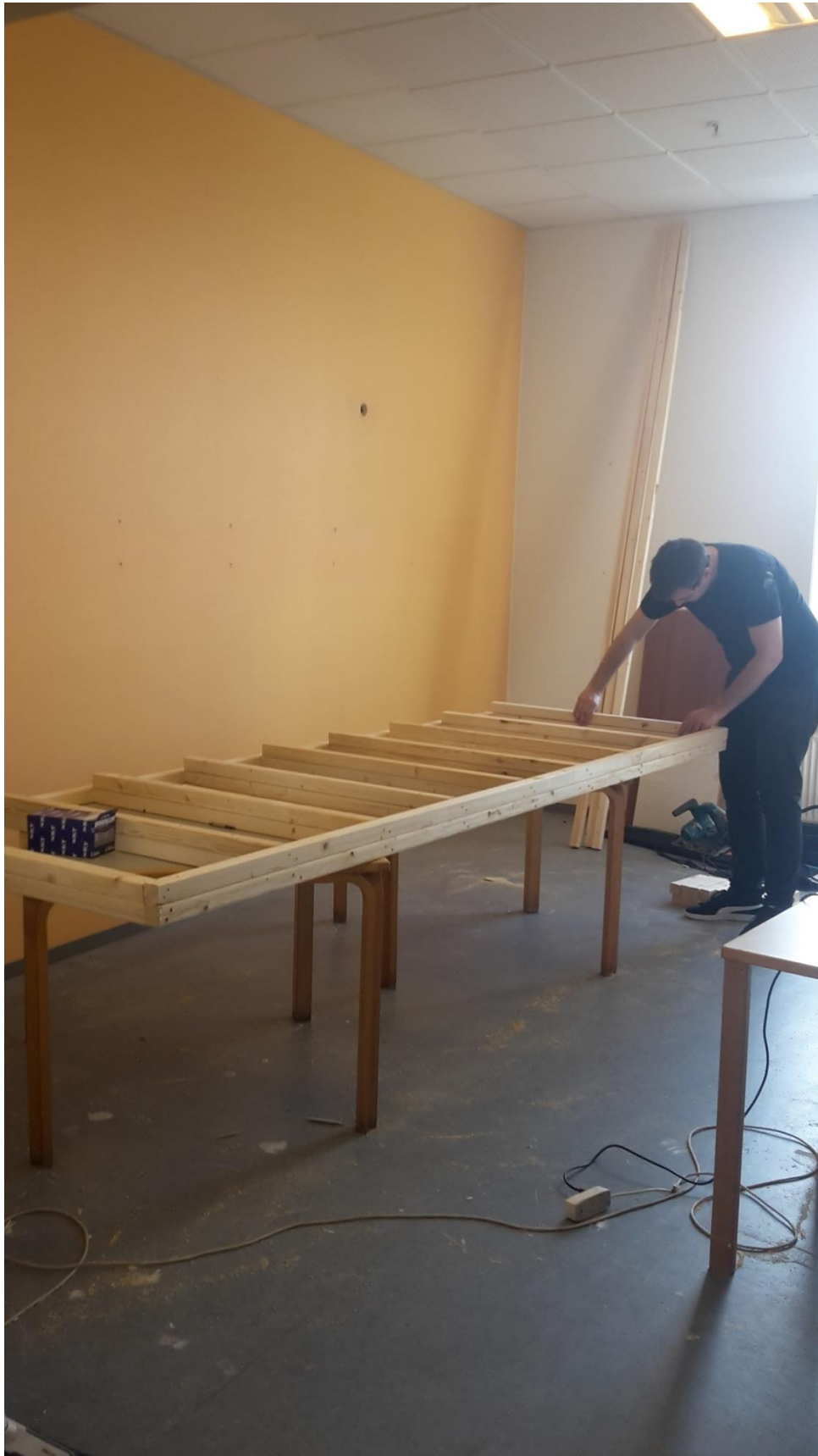
Robert bygger i Bogapoteket
